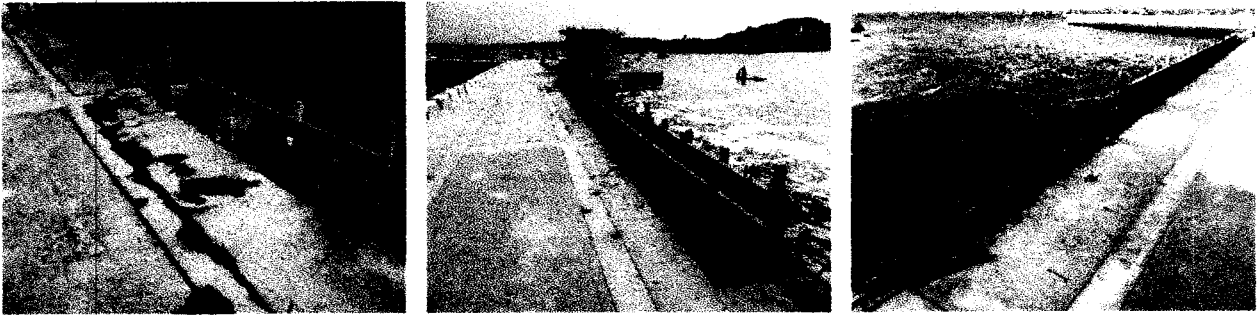
Foto 01, 02 y 03: Sardinel de concreto (Escarificado, acero y encofrado), para diseño de barandas Adicional N°04 – PUENTE DE ACCESO AL MUELLE
